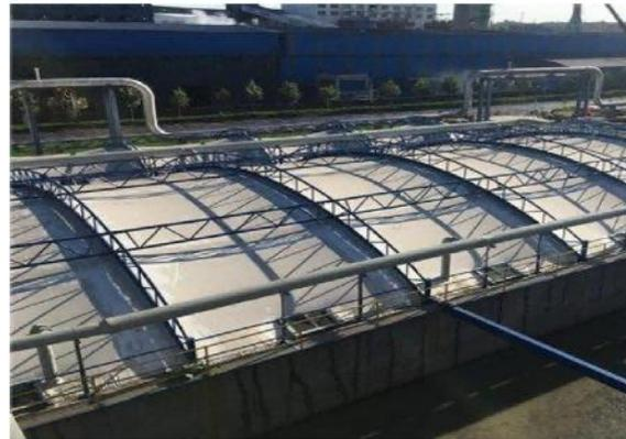
反吊膜是一种聚酯纤维材料，常被用来制作成反吊膜结构，处理污水池废气臭气体的污染问题。随着反吊膜种类和质量的提高，反吊膜材料在各行业的使用率越来越高，特别是污水池废气除臭方面。由基体和涂层两部分组成。依靠自身强大的抗拉能力，被用来制作成污水池反吊膜，污水池池体加盖使用，突破了传统结构建筑的直线设计理念，将反吊膜结构设计的曲面设计特点展露无疑，是一种结构新颖，造型优美的现代化结构设计。
